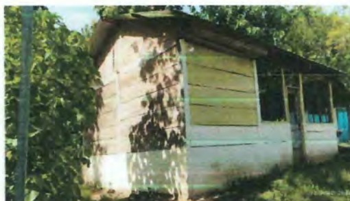
Foto 2: Sustitucion de Estructura metalica y laminas troqueladas
