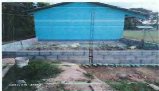
Foto 5: Instalacion de estructura metalica y laminas troqueladas
