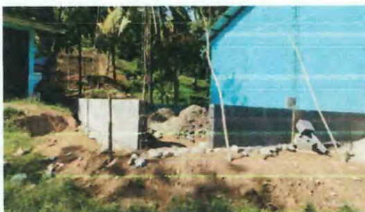
Foto 4: Instalacion de balcones de ambos lados
