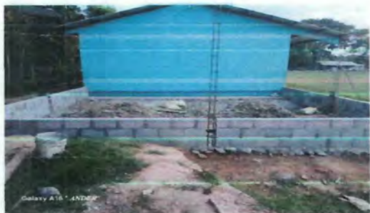
Foto 3: Modulo II, Reparacion de pared
